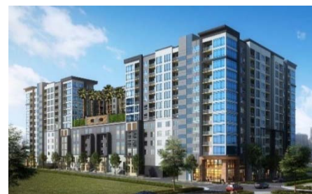
Camden Lake Eola – Orlando, FL
